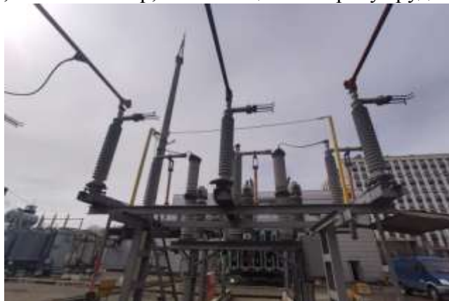
Рисунок 7 – Стойка для крепления страховочной привязи на разъединителе
