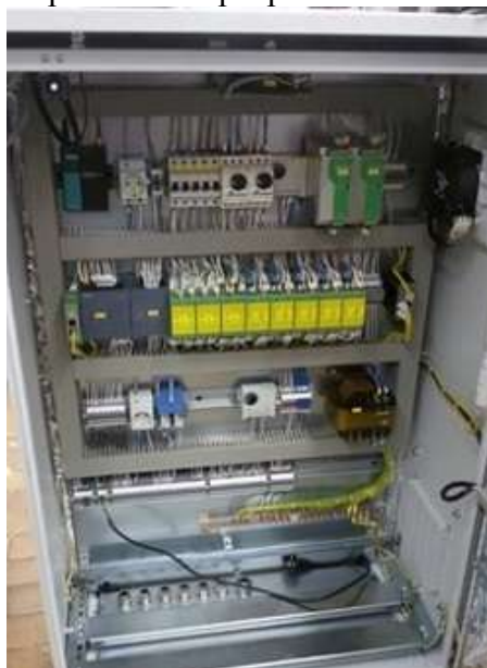
Рисунок 2 – Устройство автоматической переездной сигнализации
