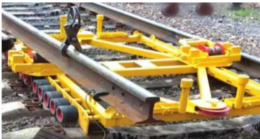
Рисунок 4 – Тележка для перекладки рельсов при перешивке пути колеи 1067 мм на колею 1520 мм
